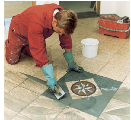
Die Fugen bei Feinsteinzeugbelägen können in einer Breite von 1 - 10 mm mit PCI FT ® Megafug verfugt werden.
