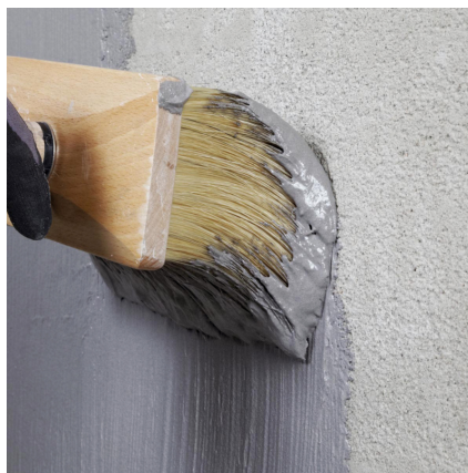
Aufbringen einer Kontaktschicht mittels Bürste oder Quast.
