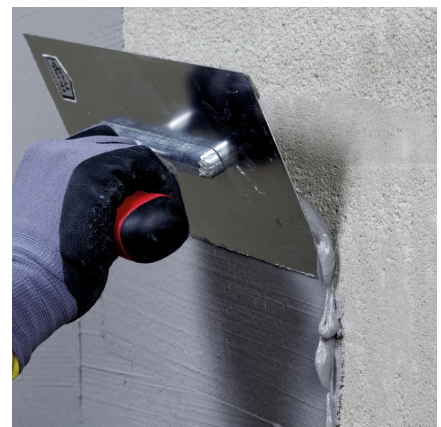
Eine Kontaktschicht kann auch in Form einer Kratzspachtelung aufgetragen werden.
