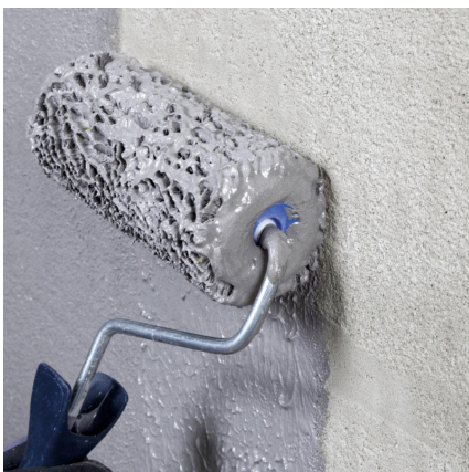
Aufbringen einer Kontaktschicht mit dem Roller.
